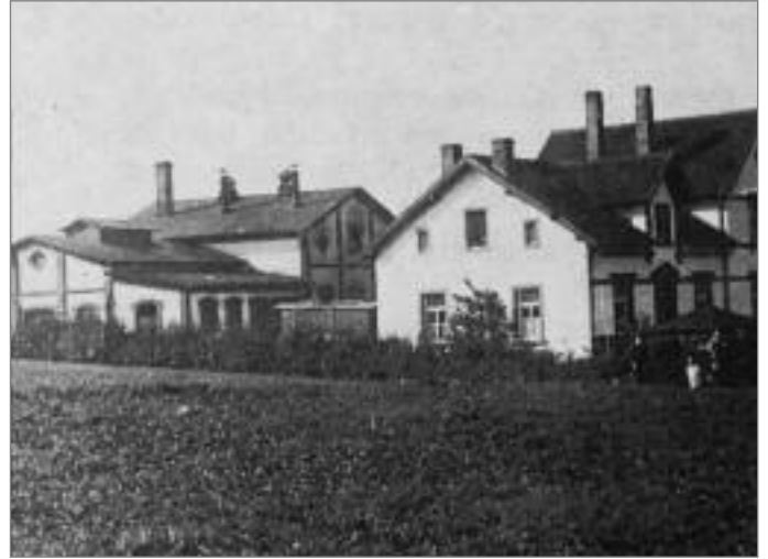
Das Gaswerk mit Ofenhaus u. Kohlenschuppen, Reinigungshaus, Regeneriererraum und Wohnhaus für Gasmeister und Heizer. (um 1910)
