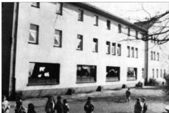
Im Jahr 2004 zog der Kindergarten St. Martin von hier aus um in das neue Pfarrheim in der Parkstraße
