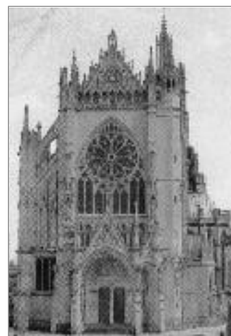
Das von Paul Tornow neu gestaltete Westportal der Metzter Kathedrale
