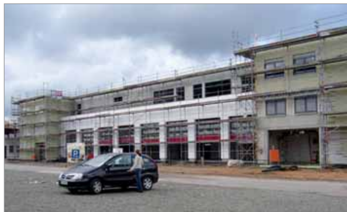
Die Firma Buwi's GmbH arbeitete am Wärmedämmverbundsystem an dem Bauvorhaben Saerwache Homburg Saar
