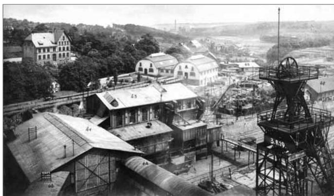
Blick von der Grube Itzenplitz durchs obere Klinkenthal. Rechts Seilscheibengerüst Schacht II. Oben Zechenhaus mit Badeanstalt und Büros
