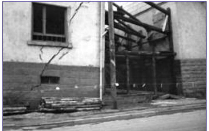
Bergleute sicherten Decken und gerissenes Mauerwerk fachkundig mit Grubenstempeln ab. Auf der Insel und auf dem Kastelberg sind ganze Straßenzüge gesperrt, weil durch die Senkungen Versorgungsleitungen beschädigt wurden.
