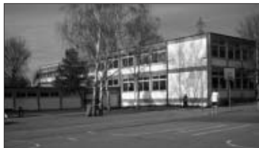
Schule in Schiffweiler
